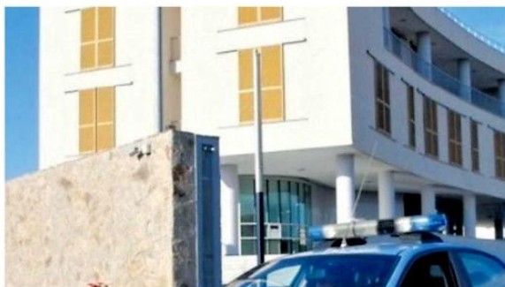
Al commissariato di via Copenaghen non funzionano i condizionatori
